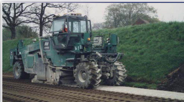
Estabilización de explanada con cemento.
