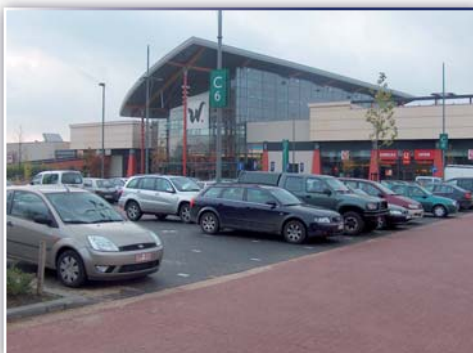
Pavimento de un aparcamiento con adoquines permeables.
