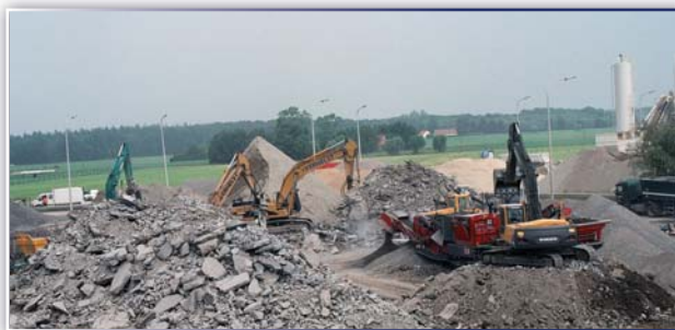
Trituración del material procedente de la demolición de un pavimento de hormigón para su empleo como árido en una base de hormigón compactado y en un pavimento de hormigón de nueva construcción (autopista A17-E403 Brujas – Kortrijk, Bélgica, 2007).
