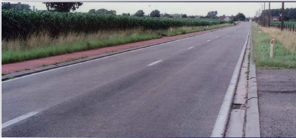
Pavimento de HAC silencioso en Herne (Bélgica).
