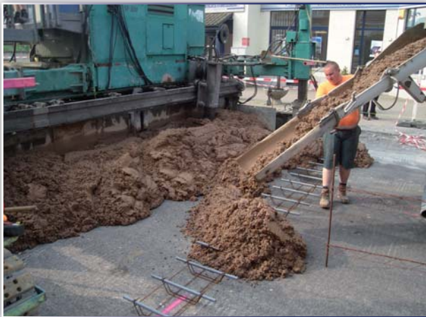
Hormigón en masa con pasadores.
