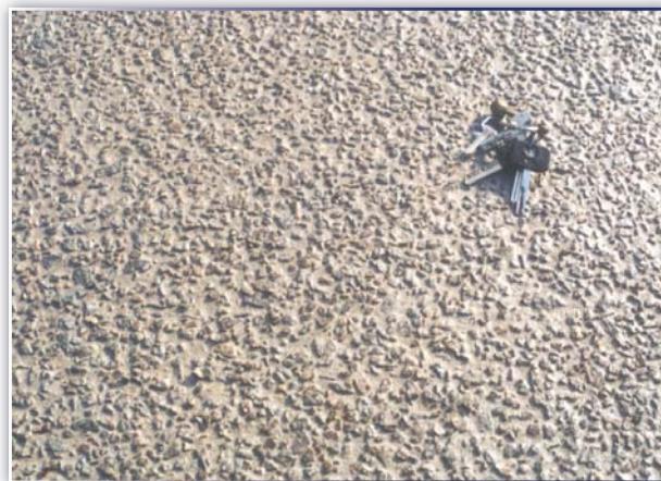
Acabado con árido visto.
