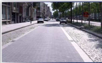
Calzadas laterales del "Leien" de Amberes (Bélgica) con adoquines porosos.
