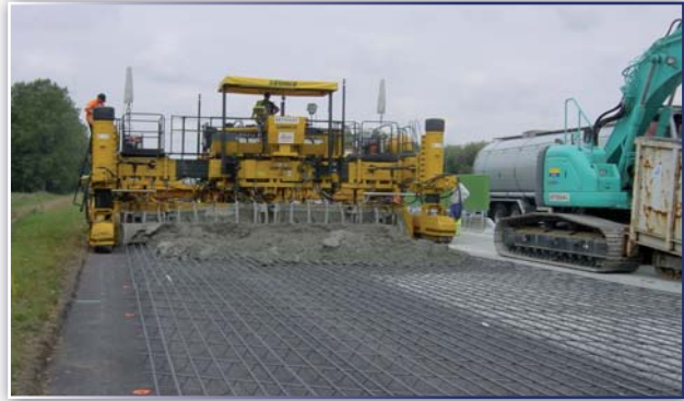
Hormigón armado continuo.
