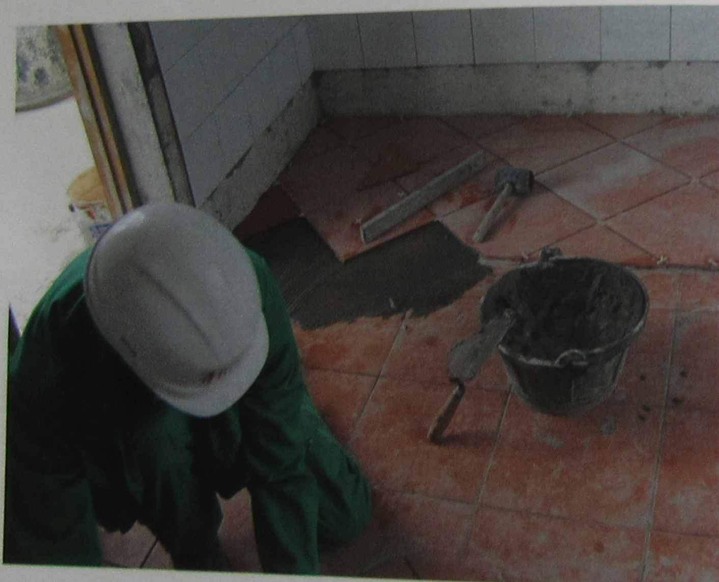
Figura 32. Puesta en obra con mortero-cola
