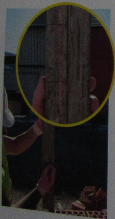
Figura 21. Marcado de las hiladas en las miras. Fuente: Obras de fábricas para revestir. Tornapunta ediciones
