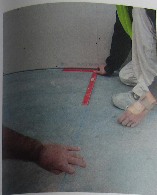
Figura 19. Replanteo de un encuentro de fábricas en ángulo recto mediante el uso de la escuadra y la cuerda de trazar. Fuente: Obras de fábricas para revestir. Tornapunta ediciones
