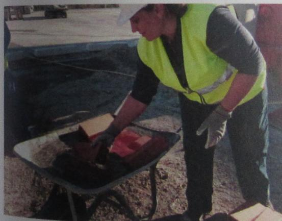
Figura 23. Ladrillos humedecidos mediante inmersión. Fuente: Obras de fábricas para revestir. Tornapunta ediciones
